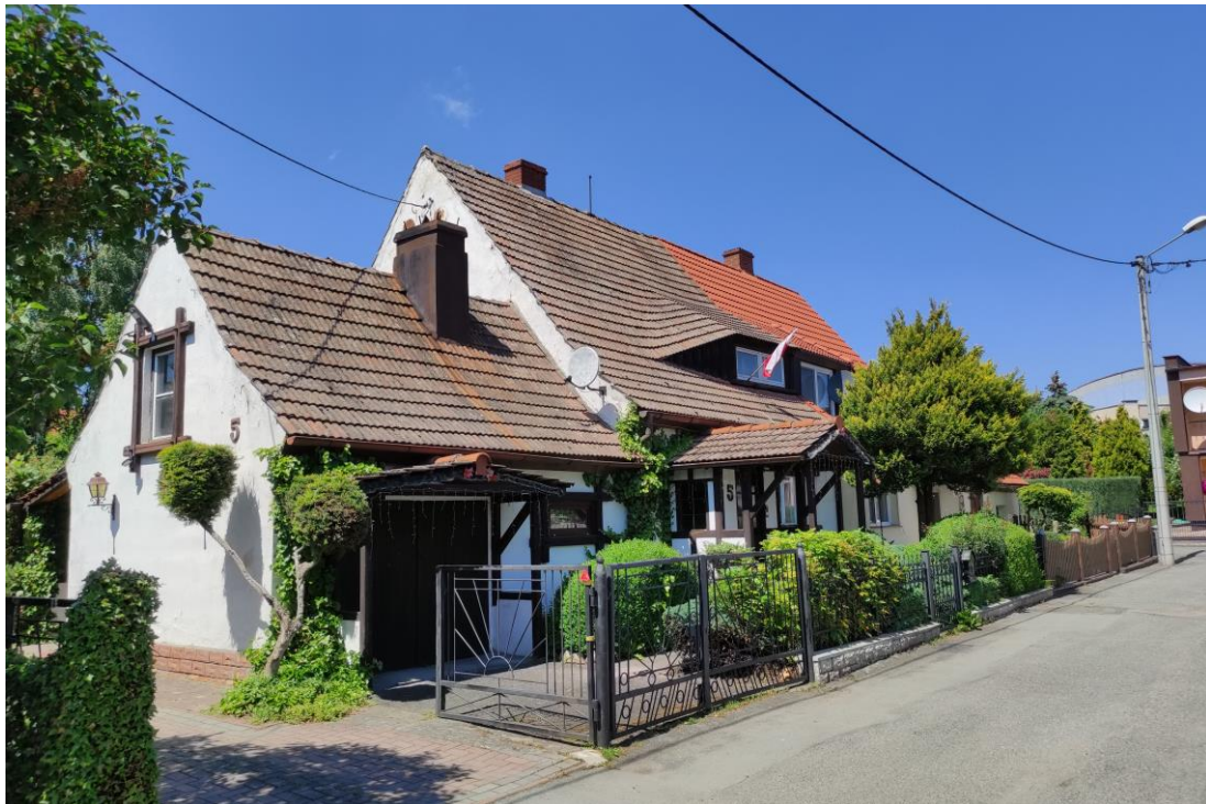
Widok budynku od południowego – wschodu.
