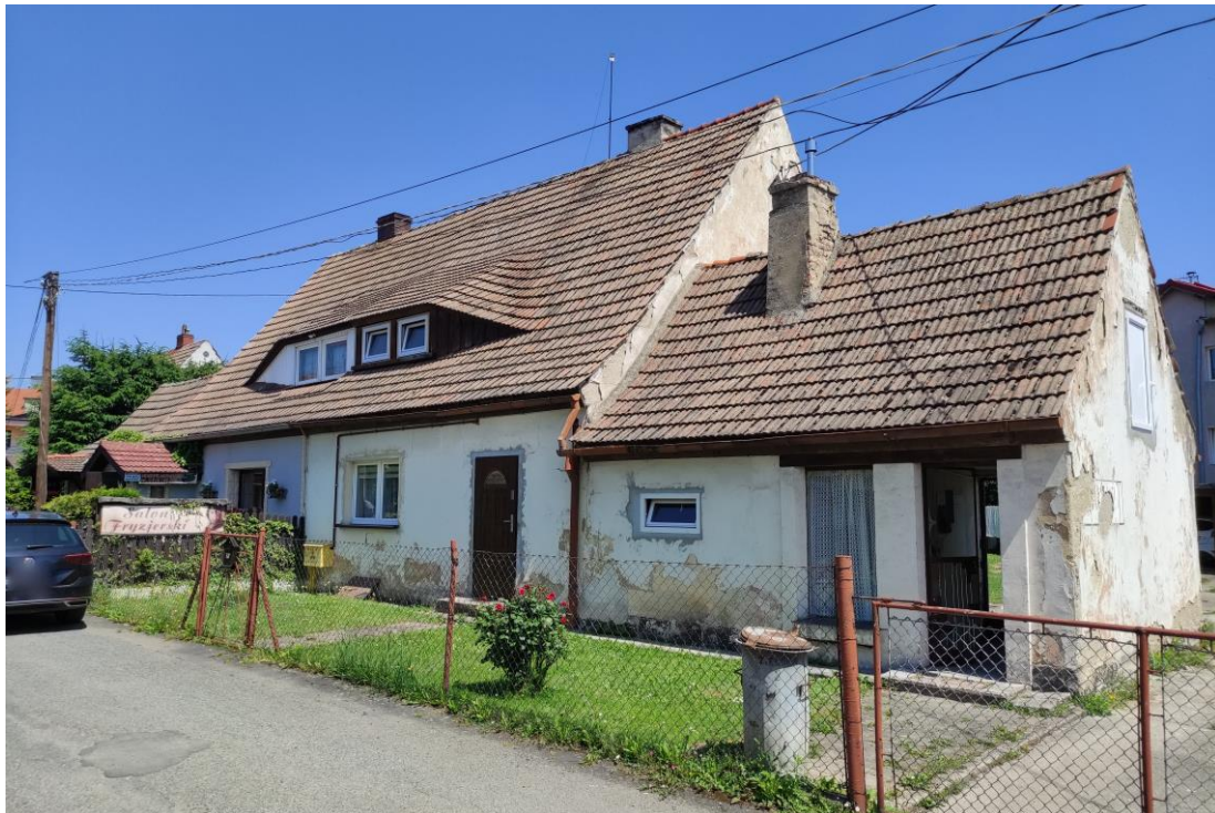
Widok budynku od południowego – zachodu.
