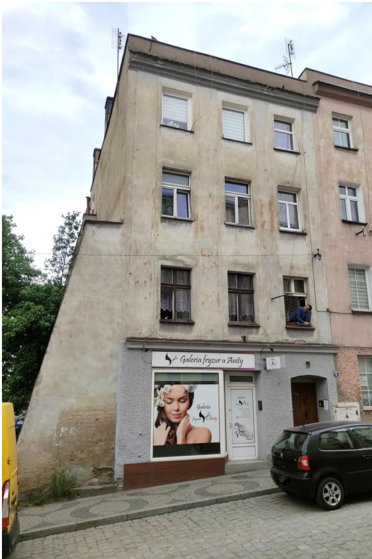
Widok budynku od północnego – wschodu.
