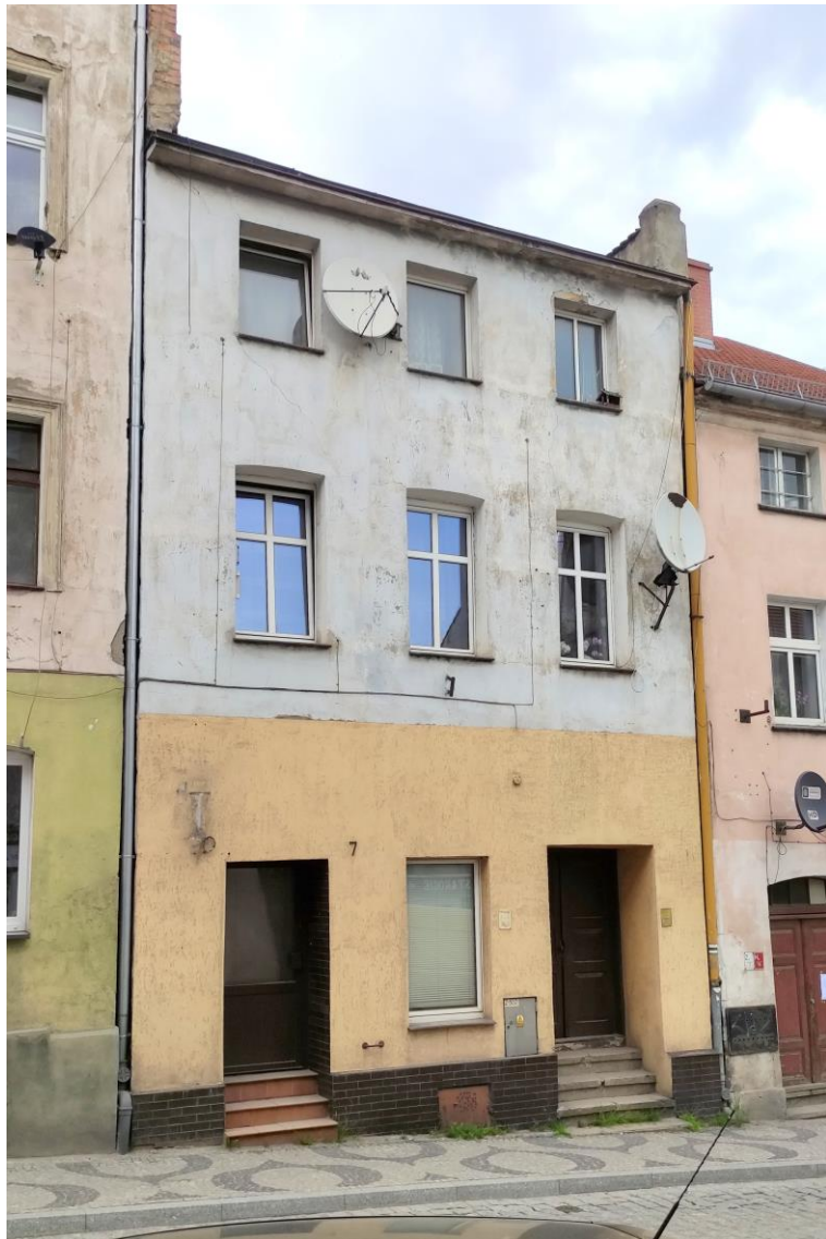
Widok budynku od południowego – zachodu.
