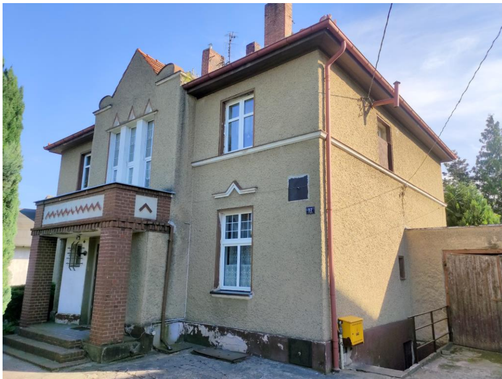
Widok budynku od północy.
