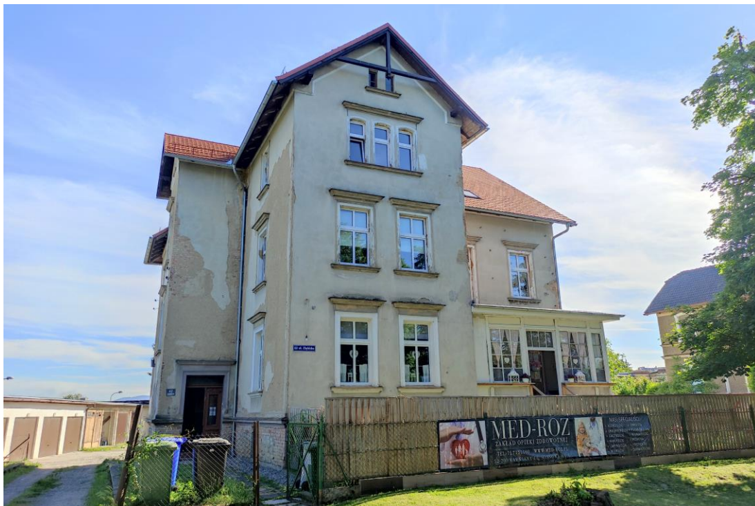
Widok budynku od północnego – wschodu.
