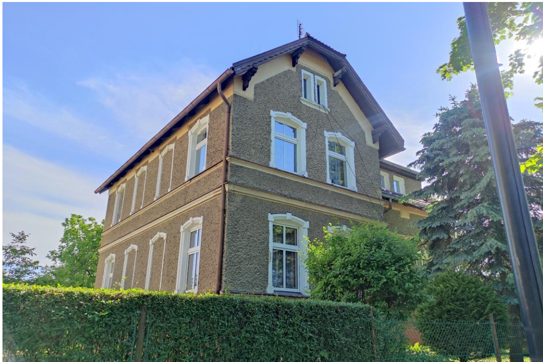
Widok budynku od północnego – zachodu.
