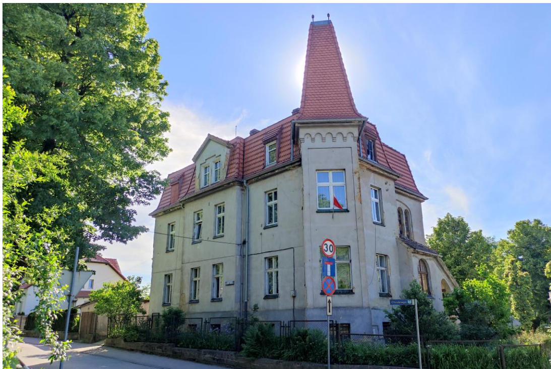
Widok budynku od północnego – wschodu.
