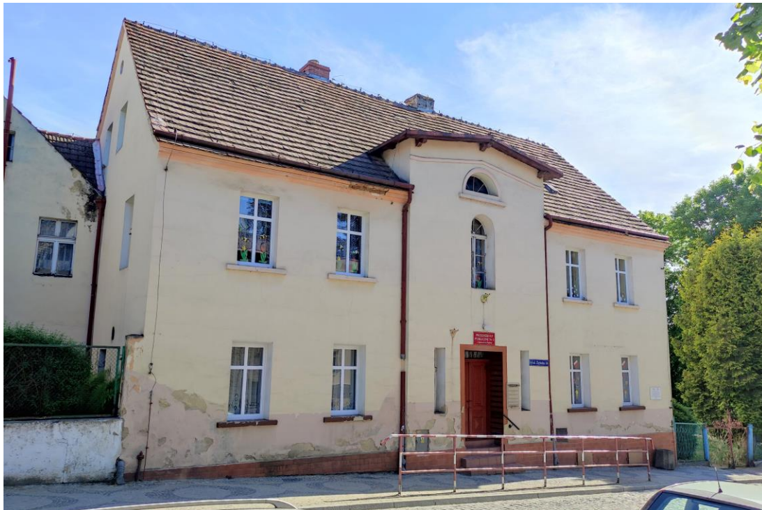
Widok budynku od północnego – wschodu.
