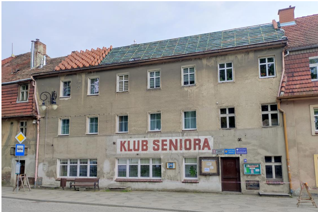
Widok budynku od północy.
