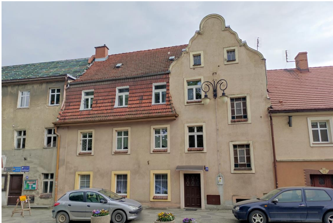
Widok budynku od północy.
