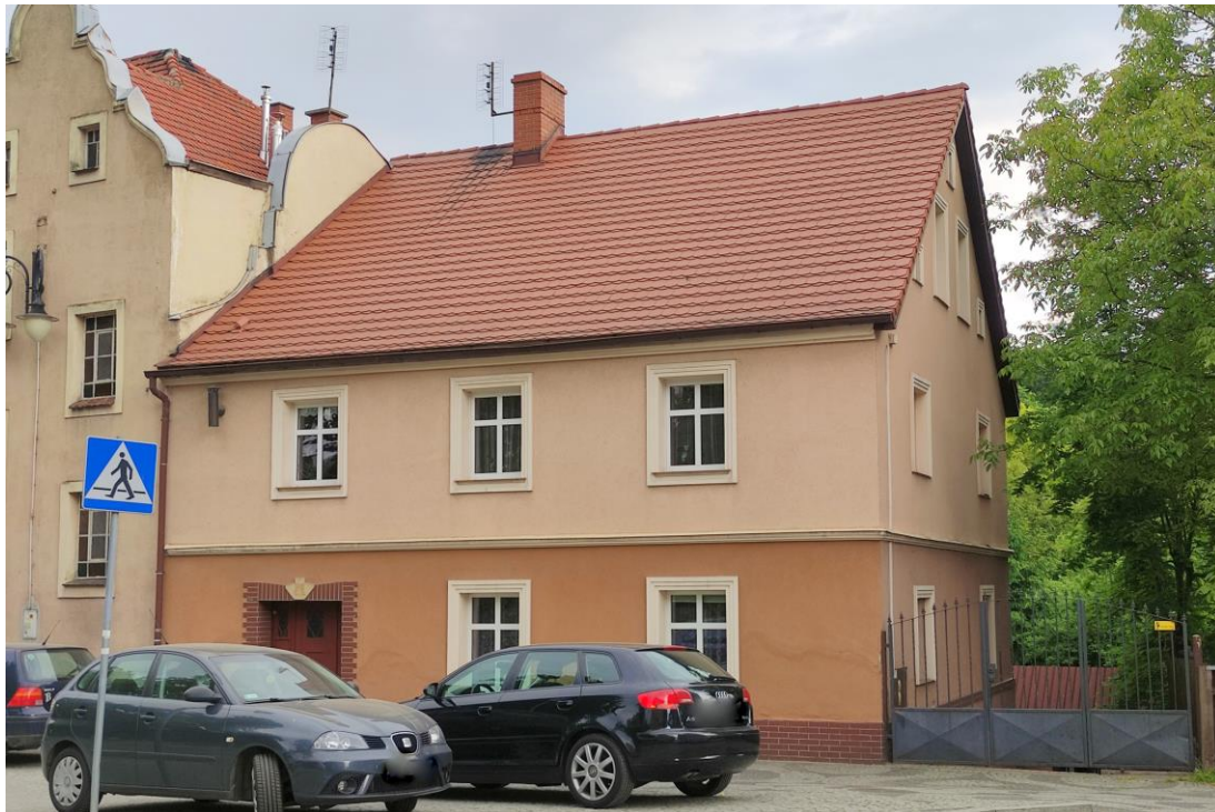
Widok budynku od północnego – zachodu.
