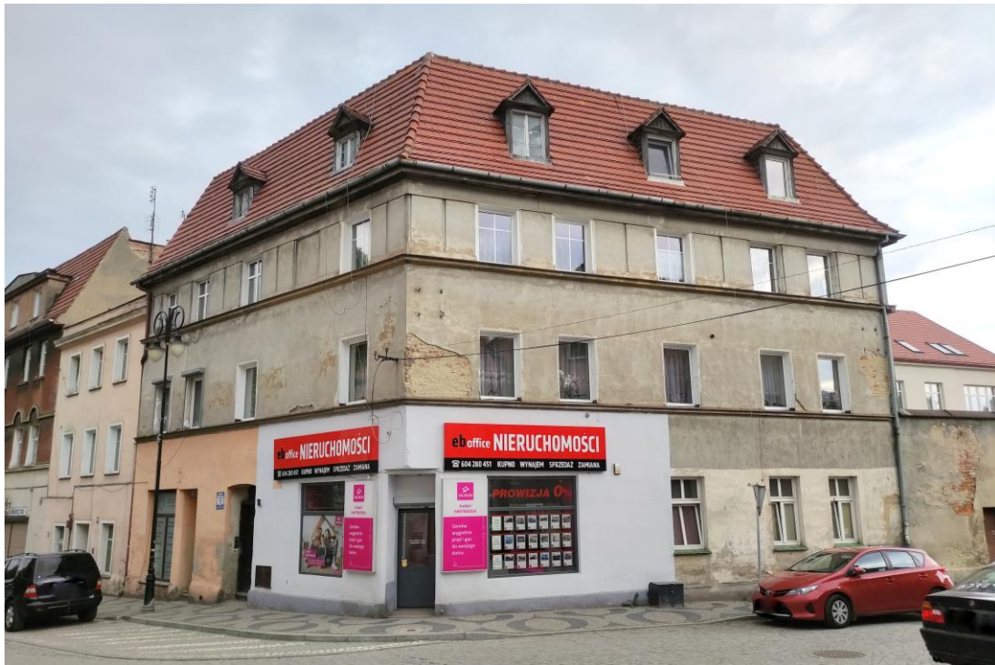
Widok budynku od północy.
