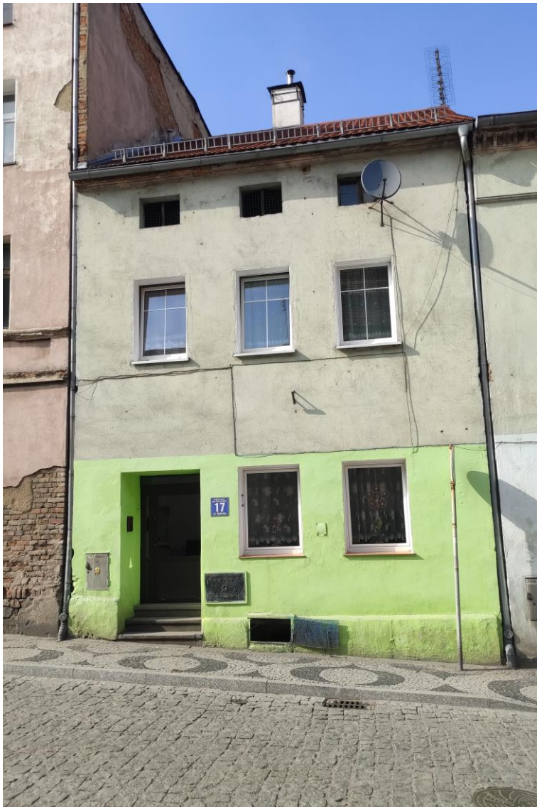
Widok budynku od południowego – zachodu.
