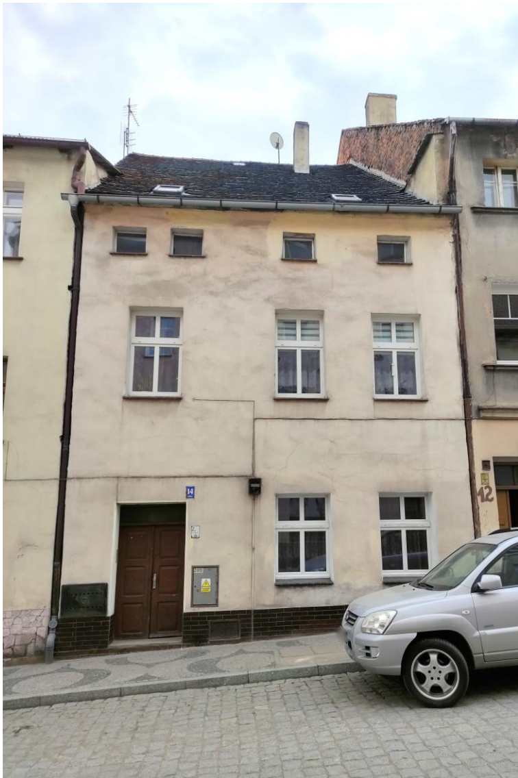
Widok budynku od północnego – zachodu.
