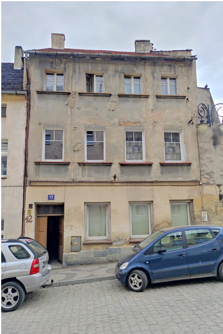
Widok budynku od północnego – wschodu.
