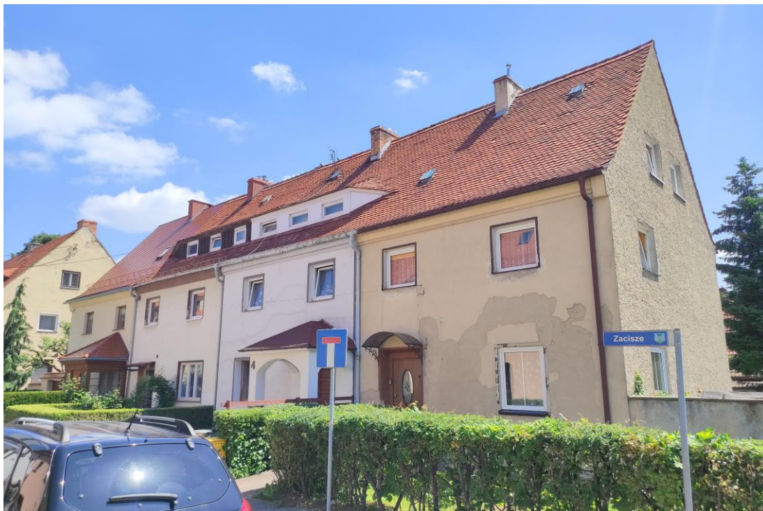
Widok budynku od południowego – zachodu.
