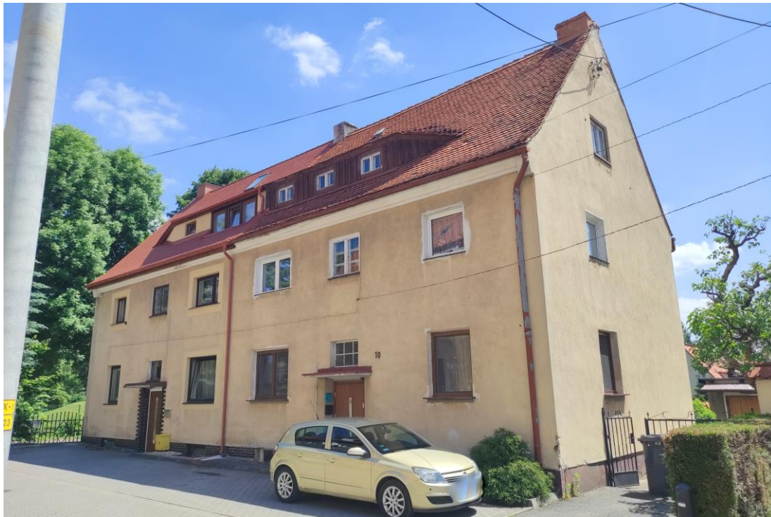
Widok budynku od północnego – zachodu.
