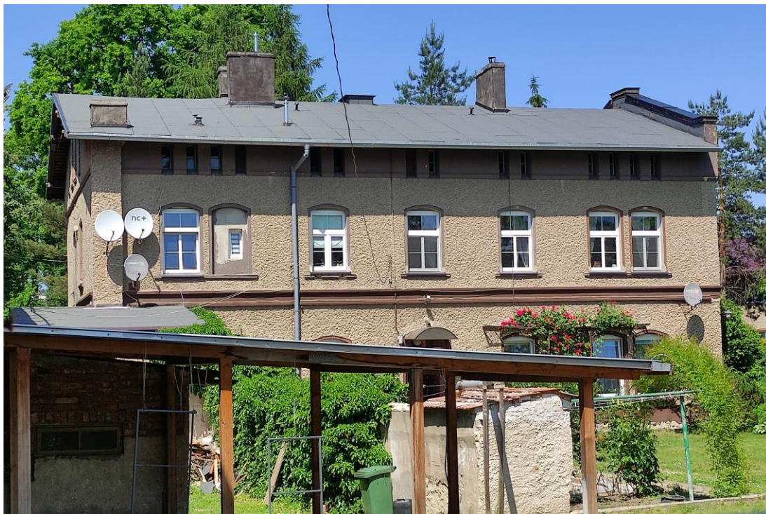
Widok budynku od południowego – wschodu.
