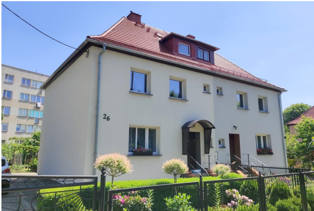
Widok budynku od północy.
