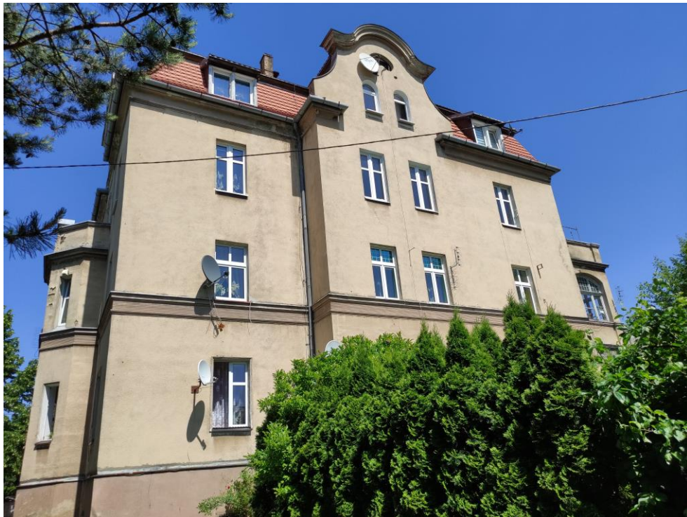
Widok budynku od południowego – zachodu.
