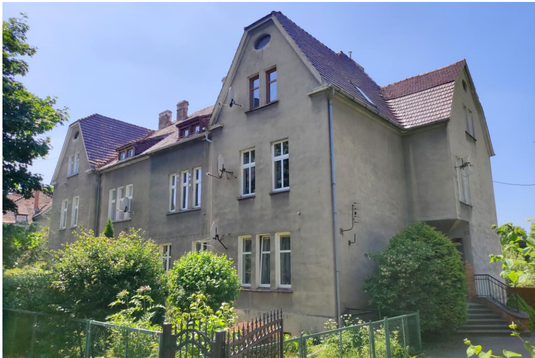
Widok budynku od wschodu.
