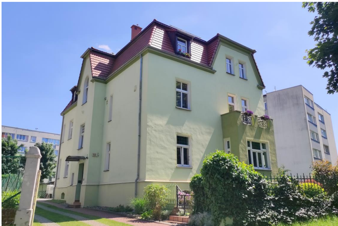
Widok budynku od północy.
