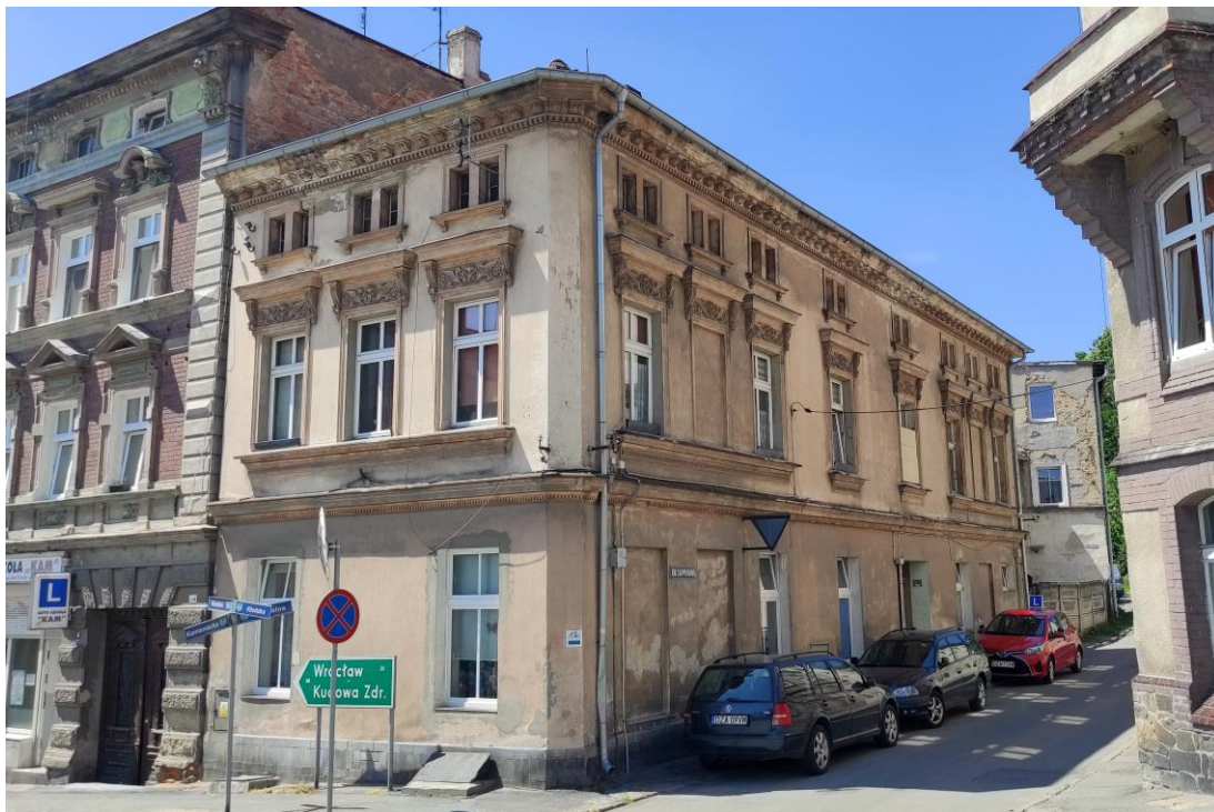
Widok budynku od północnego – wschodu
