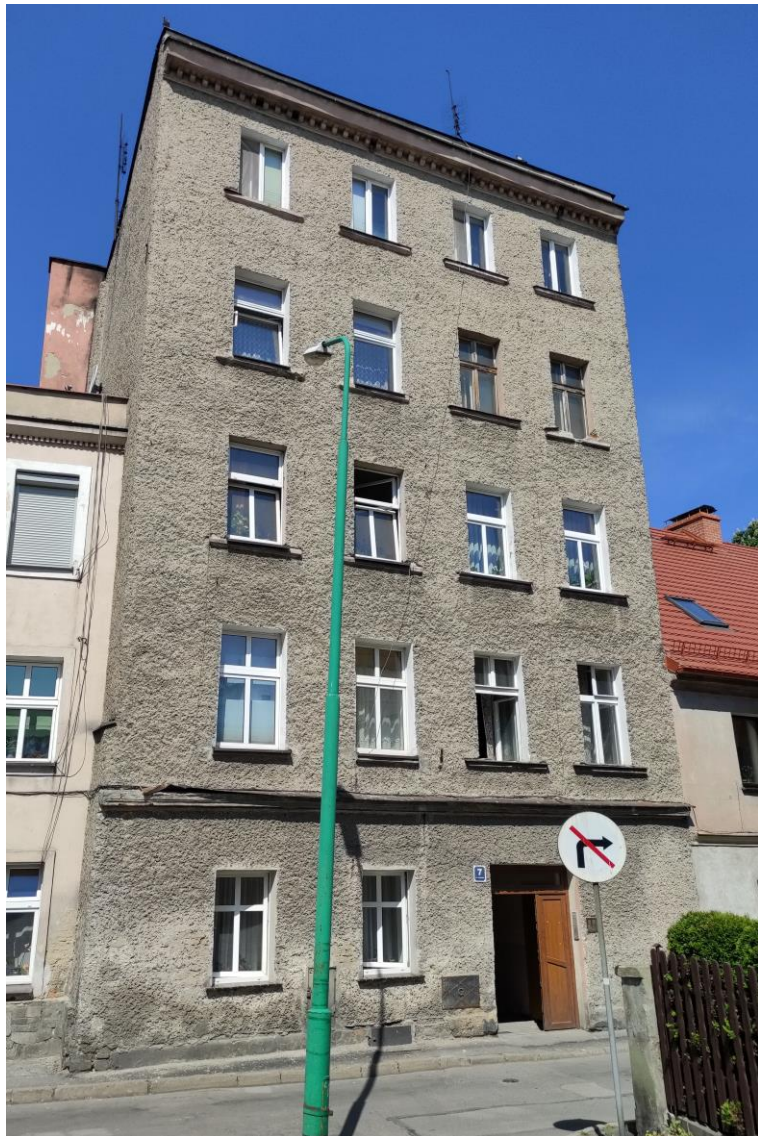
Widok budynku od południowego – wschodu.
