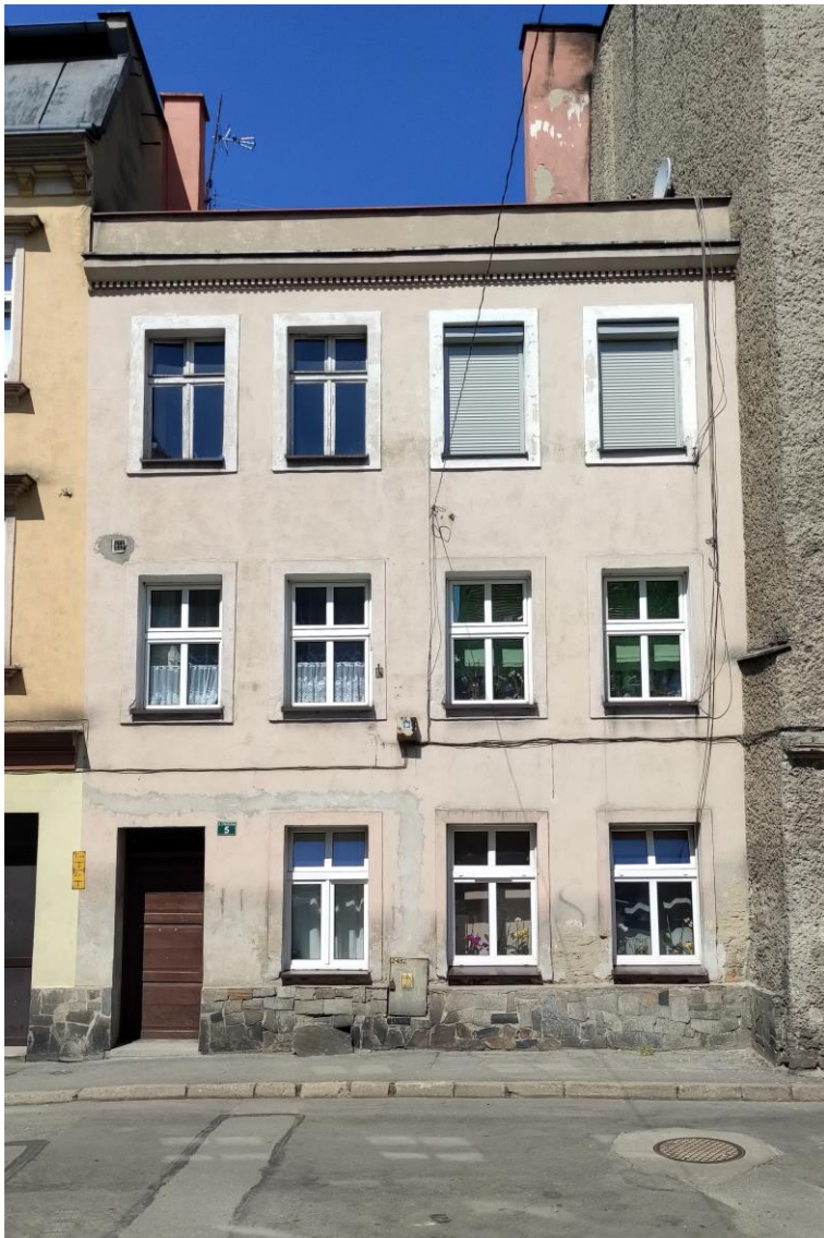
Widok budynku od wschodu.
