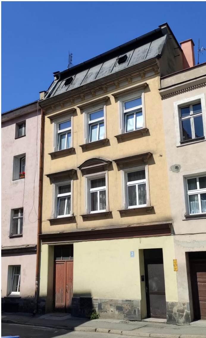
Widok budynku od północnego – wschodu.
