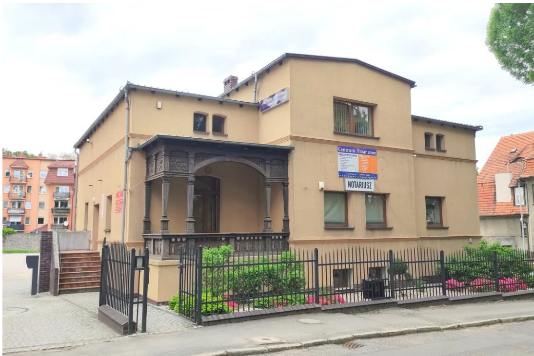
Widok budynku od południowego – zachodu.
