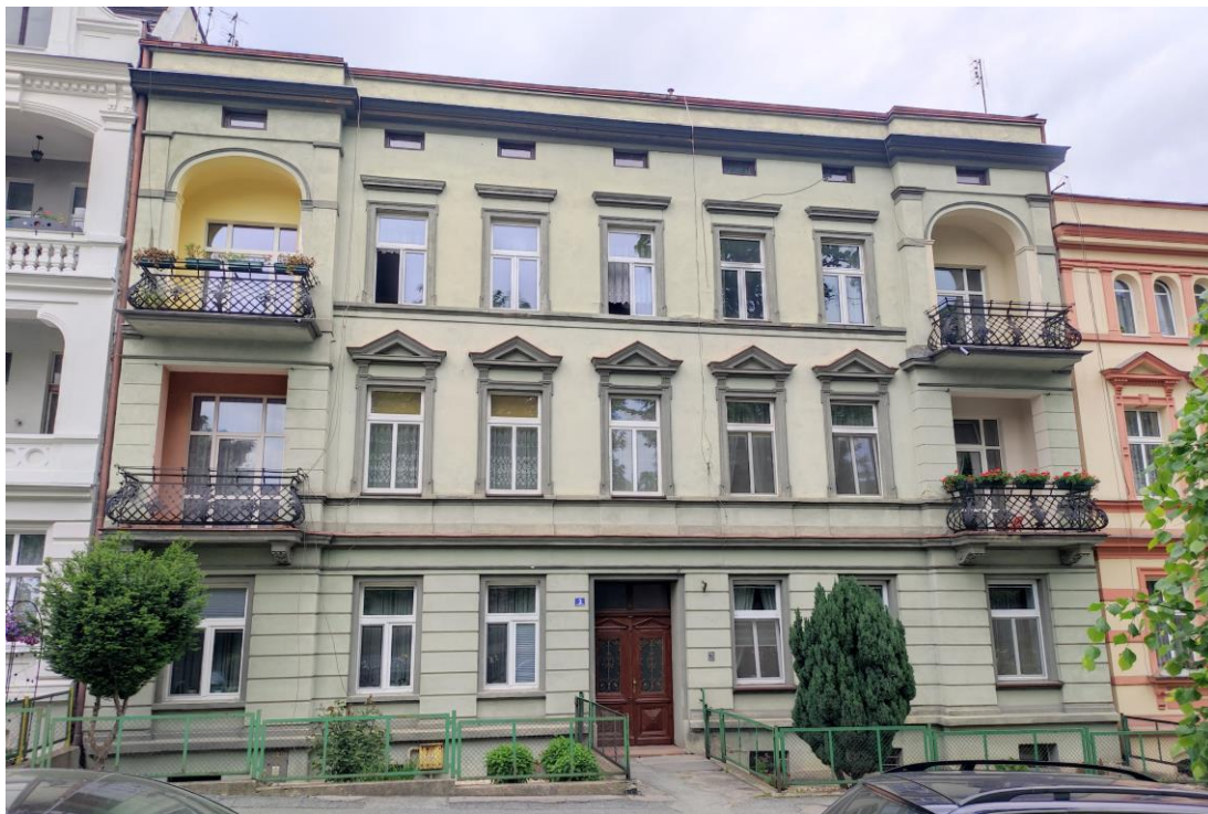
Widok budynku od południowego – zachodu.
