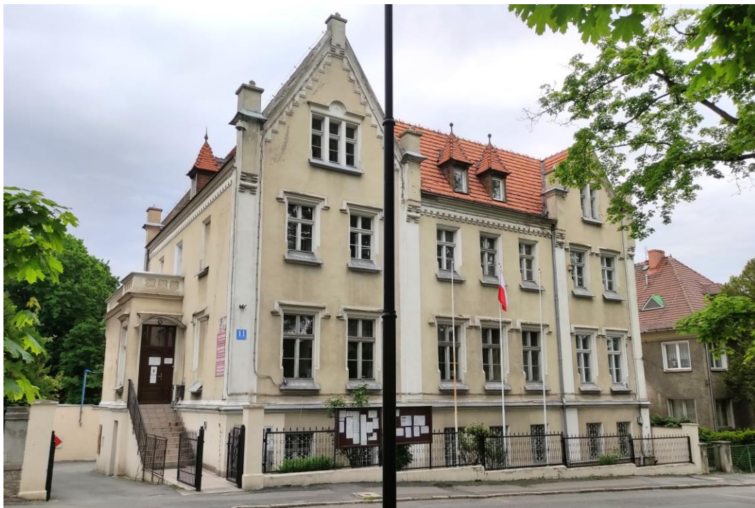
Widok budynku od południowego – zachodu.
