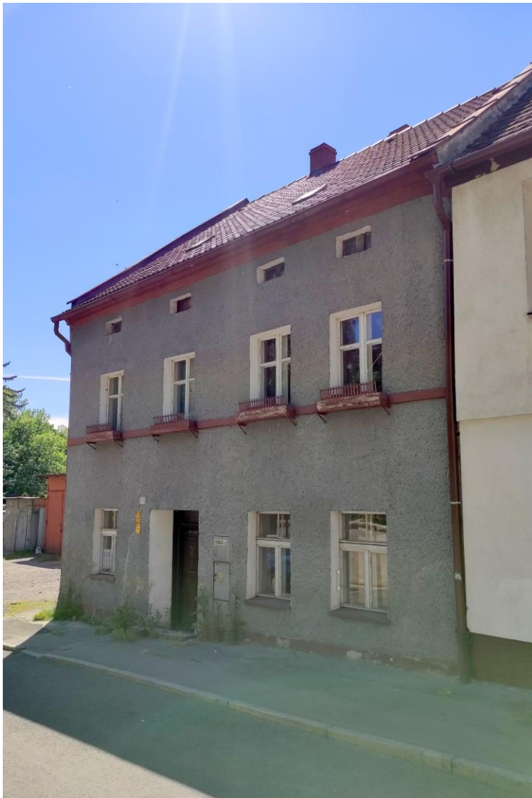
Widok budynku od północnego – wschodu.
