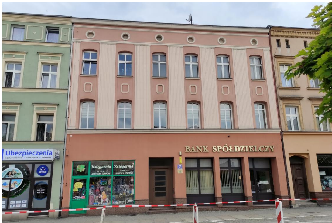
Widok budynku od południowego – wschodu.
