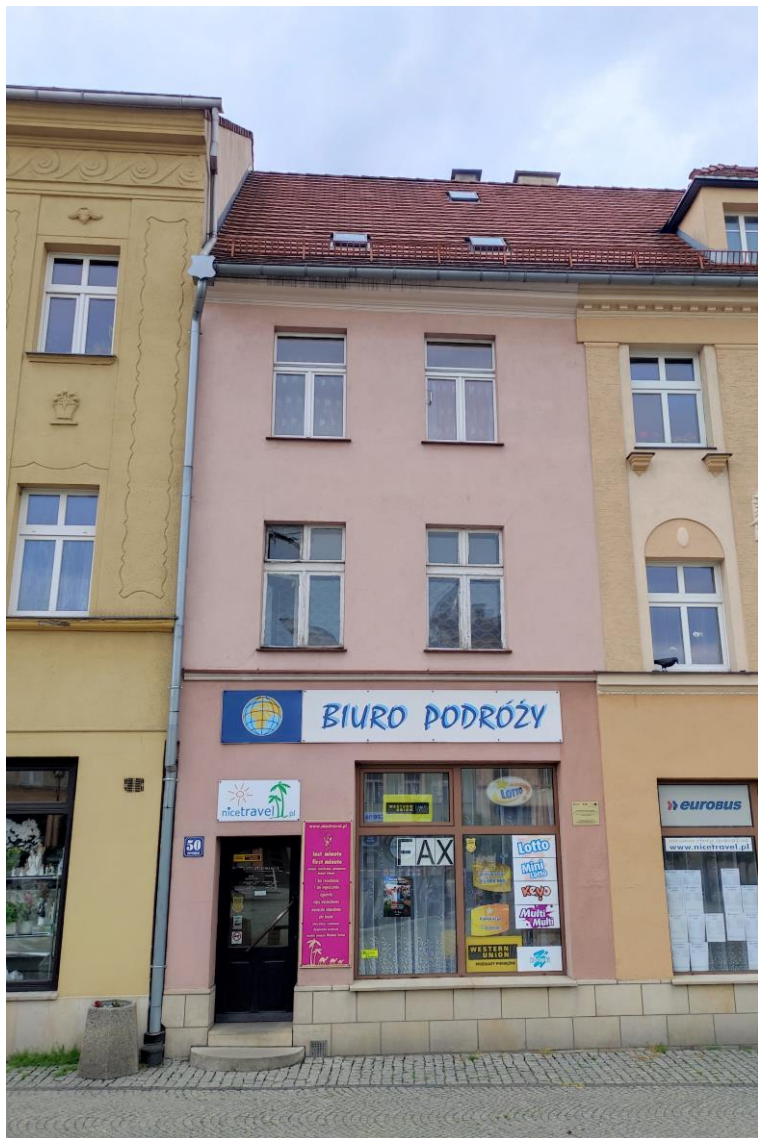
Widok budynku od północnego – zachodu.
