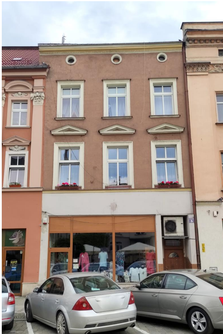
Widok budynku od południowego – wschodu.
