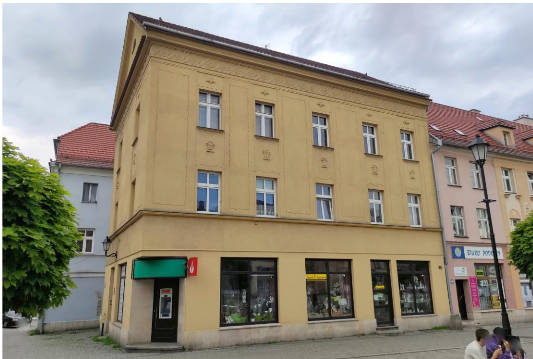
Widok budynku od północnego – zachodu.
