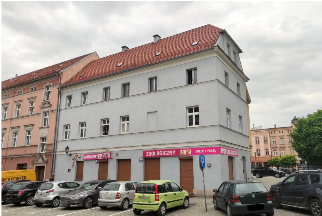
Widok budynku od północnego – wschodu.
