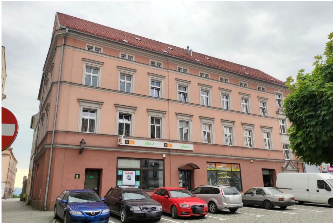
Widok budynku od południowego – wschodu.
