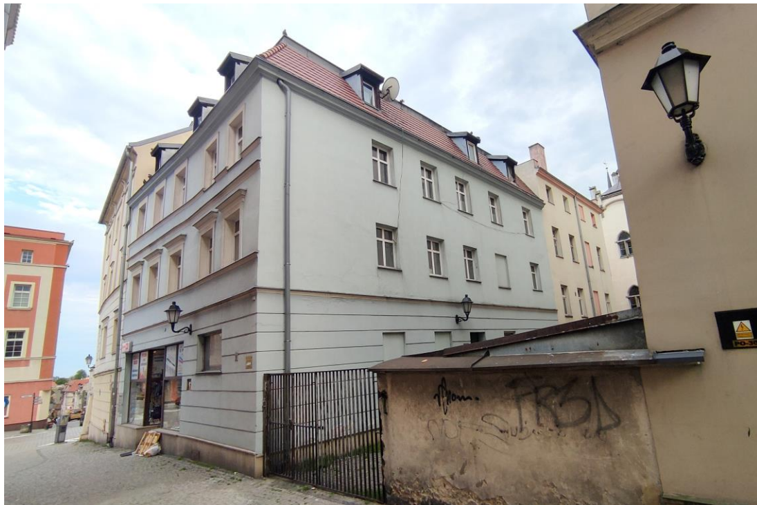
Widok budynku od północnego – zachodu.
