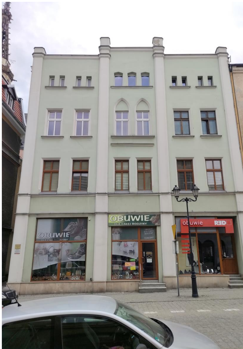
Widok budynku od południowego – wschodu.
