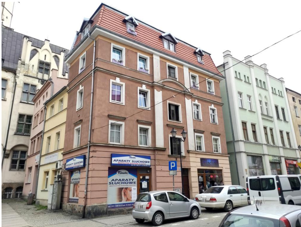
Widok budynku od południowego – wschodu.
