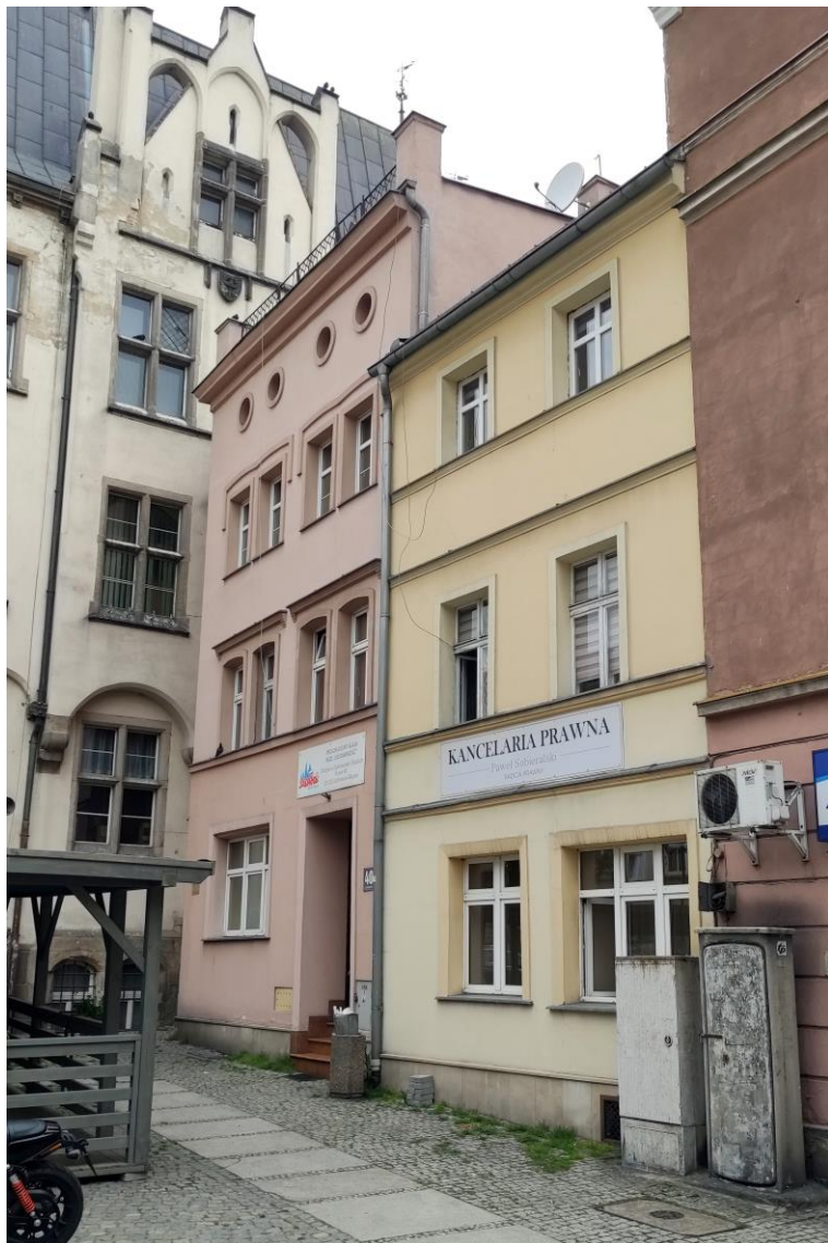
Widok budynku od południowego – wschodu.
