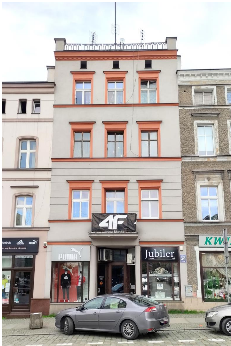
Widok budynku od północnego – wschodu.
