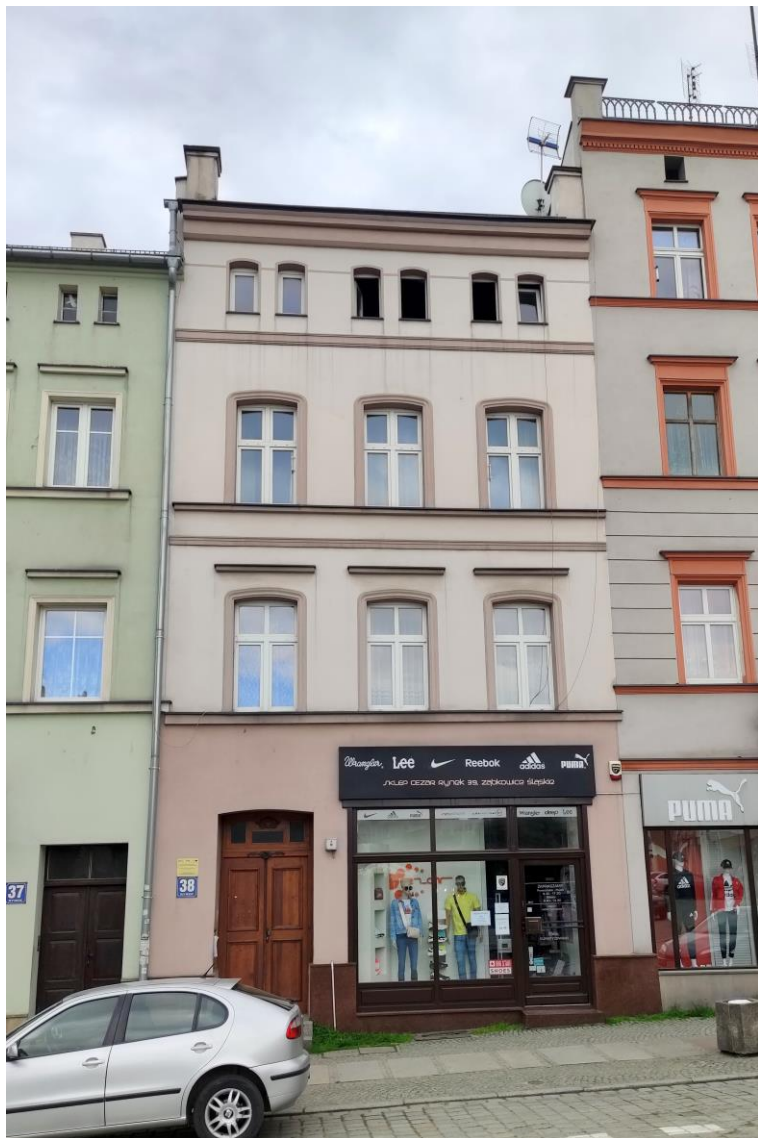
Widok budynku od północnego – wschodu.
