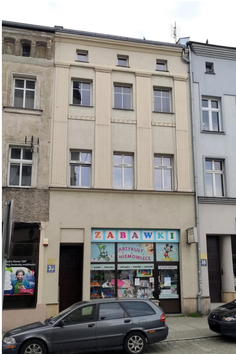
Widok budynku od północnego – wschodu.
