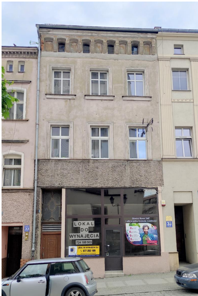
Widok budynku od północnego – wschodu.
