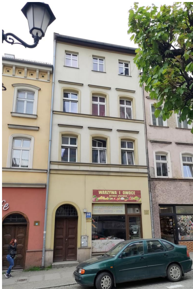
Widok budynku od północnego – wschodu.
