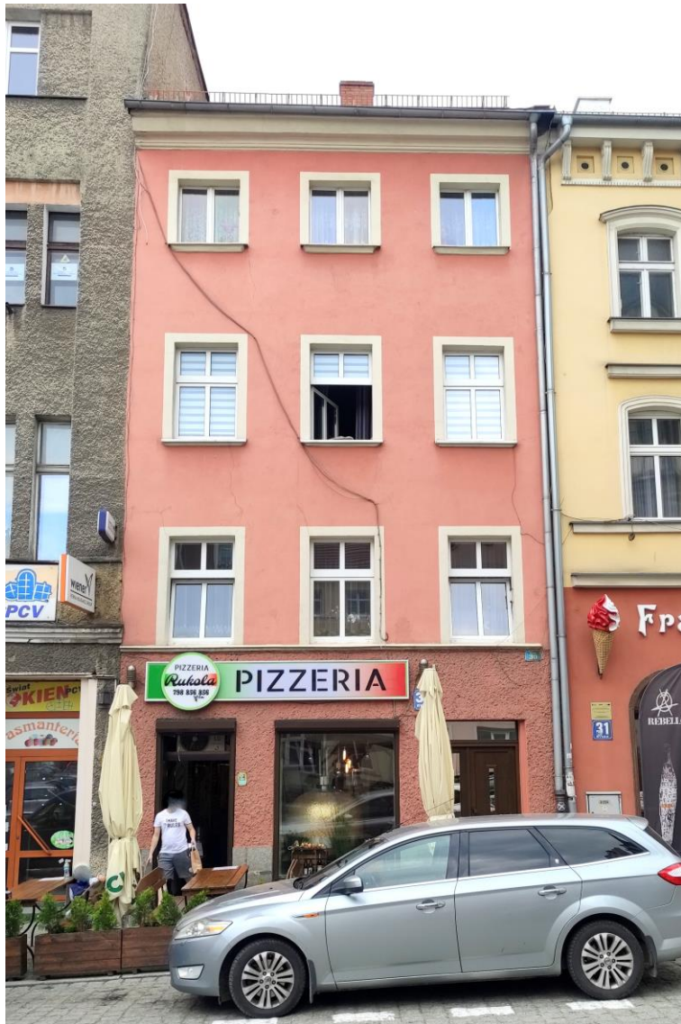
Widok budynku od północnego – wschodu.
