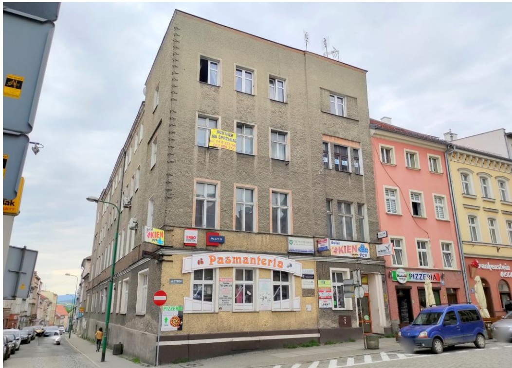
Widok budynku od północnego – wschodu.
