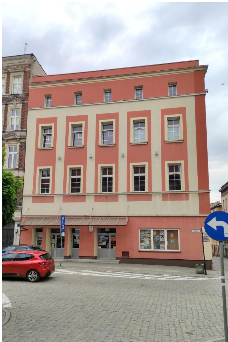
Widok budynku od północnego – zachodu.
