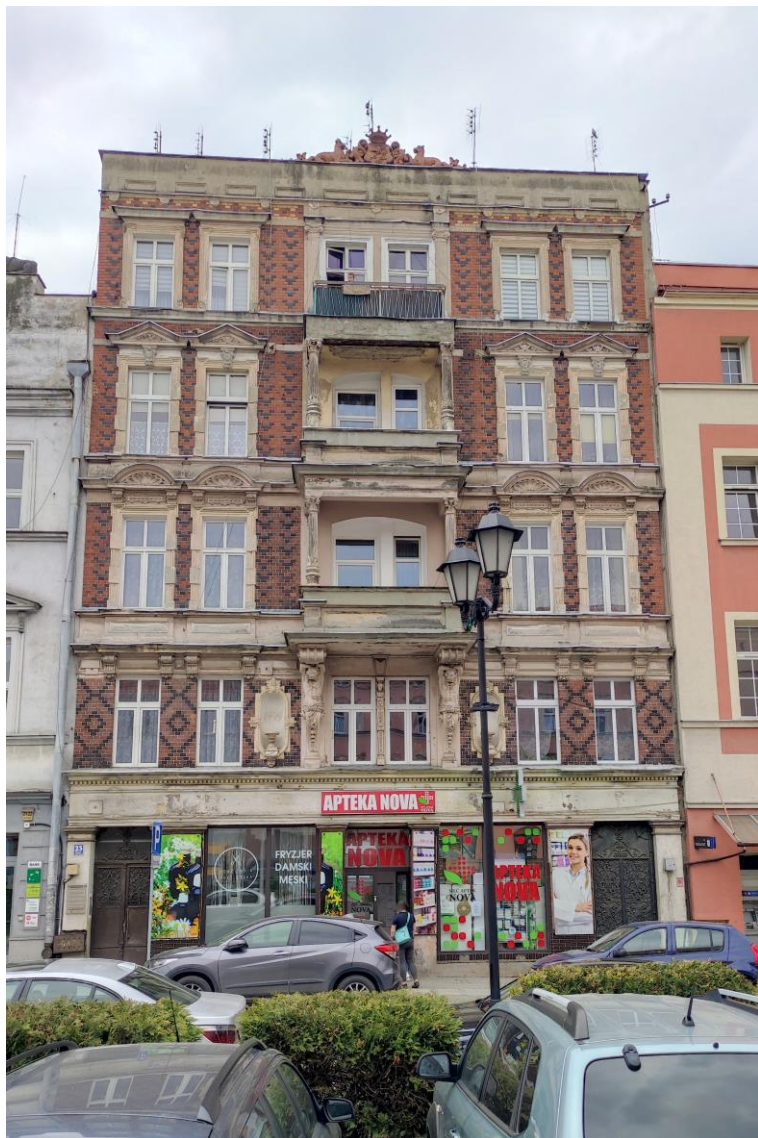
Widok budynku od północnego – zachodu.
